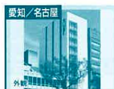
ホテル・アンドールーム名古屋伏見
