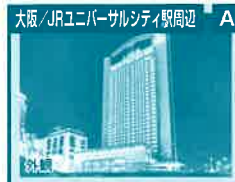
ホテル京阪 ユニバーサルタワー
